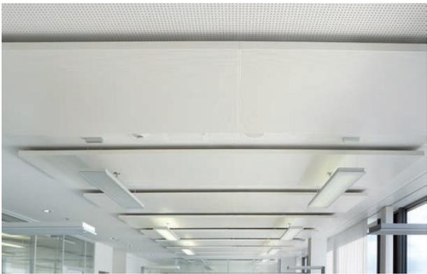
Bild 6: Multifunktionssegel über die Traversen geschoben
