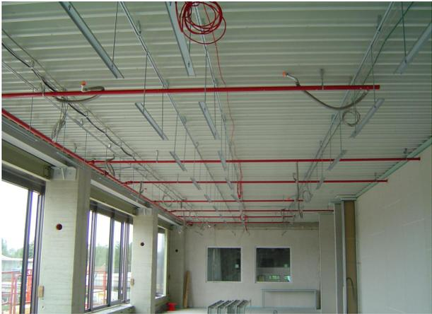
Bild 5: Zur Montage werden die Hängetraversen mittels Gewindestangen von der Rohdecke abgehängt und ausgerichtet
